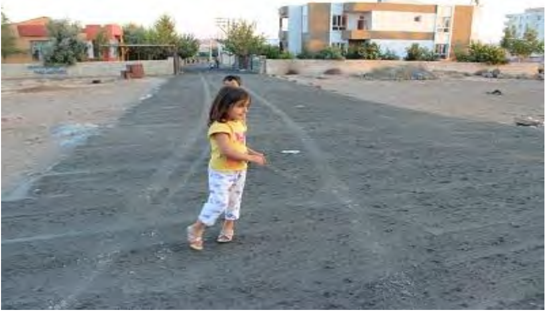
50. Fırat mah.13. sok beton alıřması tamamlandı.(2500 m2)
