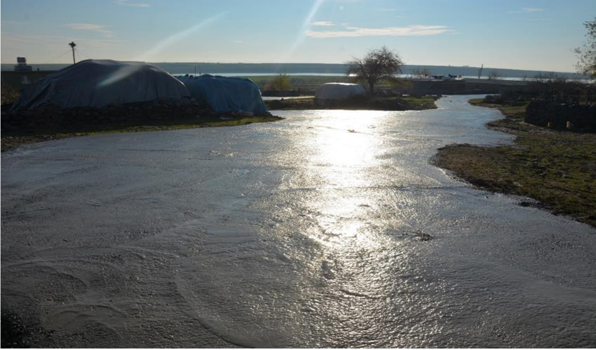
Gönüllü Kırsal Mahallesi Beton Yol Çalışması
