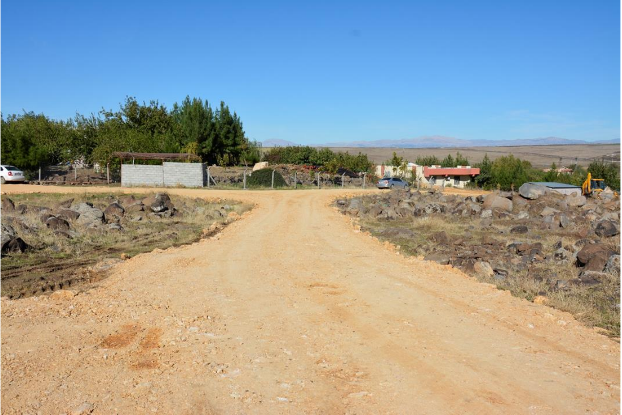
Üzümlü Kırsal Mahallesi Stabilize Yol Çalışması
