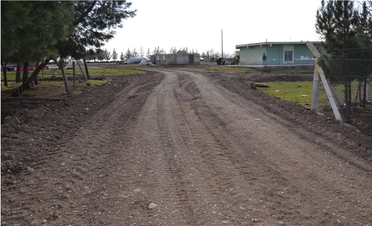
Özenpınar Kırsal Mahallesi Stabilize Yol Çalışması
