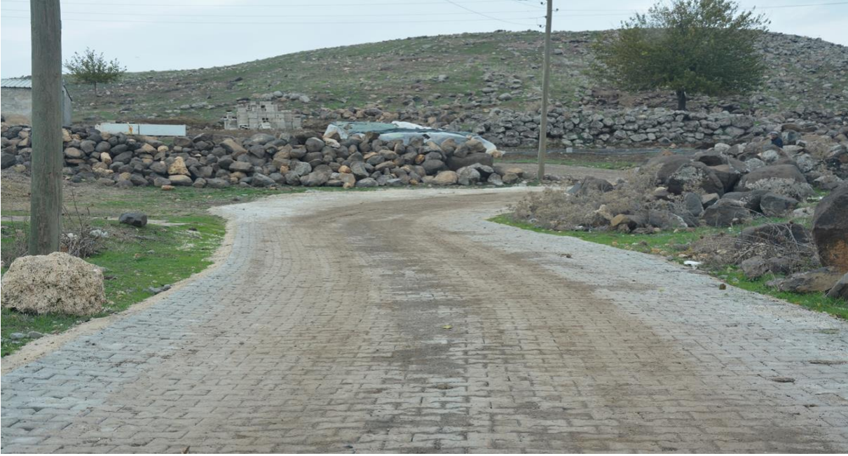
Yağızlar Kırsal Mahallesi Kilitli Parke Taşı Çalışması
