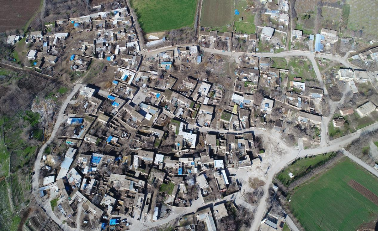
Çaylarbaşı Kirsal Mahallesi Kilitli Parke Taşı Çalışması
