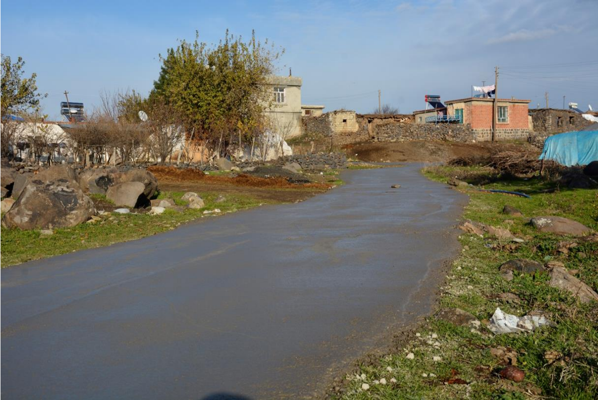
Gönüllü Kırsal Mahallesi Beton Yol Çalışması
