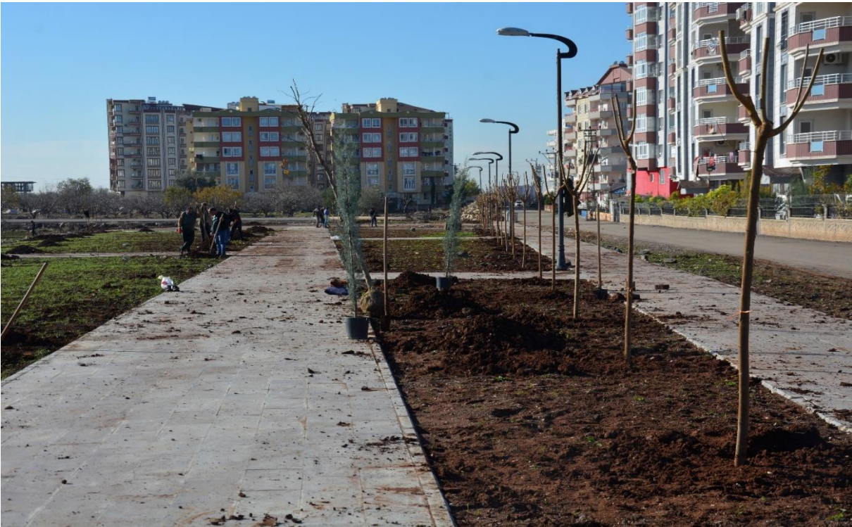
27-İlçemiz Ayvanat Mahallesi 3.Küme evleri (Huzur kent sitesi yanındaki) park yapım çalışmasına tamamlandı
