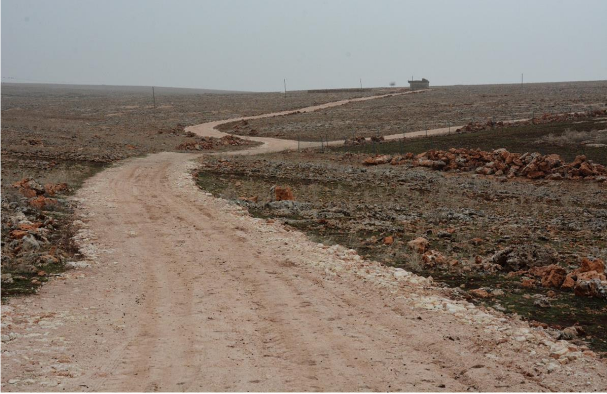
Ekili Kırsal Mahallesi Stabilize Yol Çalışması
