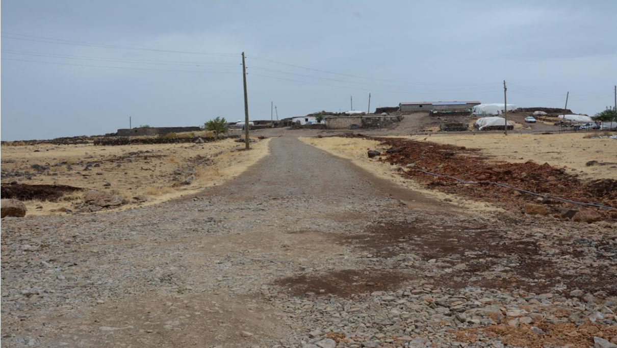
Defere Kırsal Mahallesi Stabilize Yol Çalışması
