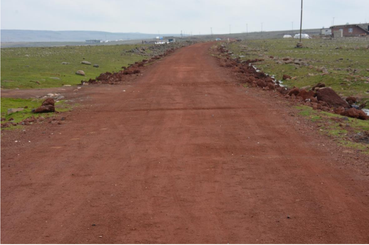
Doğukent Kırsal Mahallesi Stabilize Yol Çalışması
